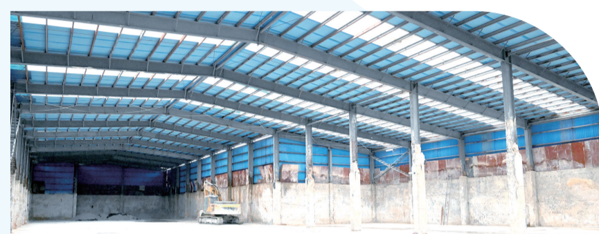
现已清空含钨废渣的库房。
