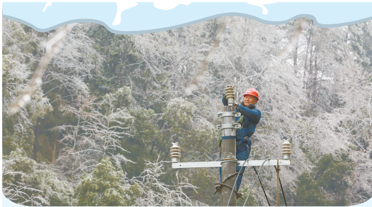
2月7日，隆回县司门前镇，电力运维人员进行除冰抢修。国网隆回县供电公司积极开展抗冰保网等行动，对10千伏线路进行除冰工作，清除线路及其通道隐患，确保老百姓温暖过年。 曾勇 郭贤文 摄影报道(湖南图片库)
