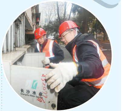
2月7日，长沙供水有限公司城西分公司麓山片区工作人员对科教新村小区户外水管进行检查。该片区供水工作人员坚守岗位，全力保障10多个老旧小区供水。 湖南日报全媒体记者 田超 王文 摄影报道
