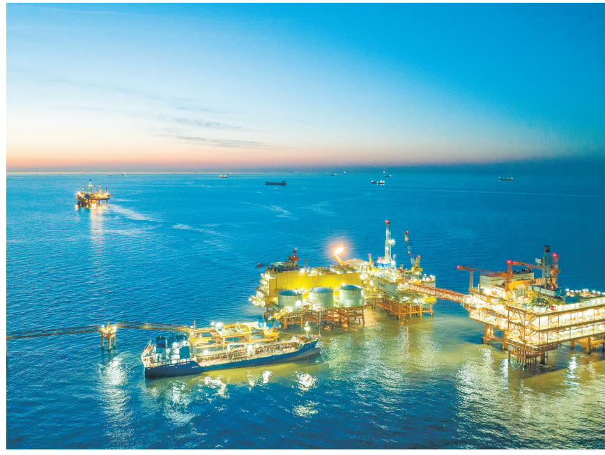
1月25日，位于渤海湾西南部的埕北油田油气处理与岸电设备共建平台——CEPC（中心平台）正式投产，该平台可使油田接入来自陆地的绿色电力，减少海上“自发电”带来的天然气和原油消耗。图为当日拍摄的埕北油田全景（无人机照片）。 新华社发
