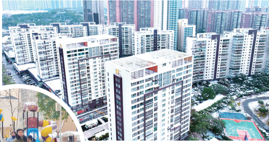
▲ 湖南湘江新区麓谷街道锦绣社区麓山润城小区启动外立面改造。目前小区8栋住宅建筑已改造完毕。本文图片均为范远志 摄
