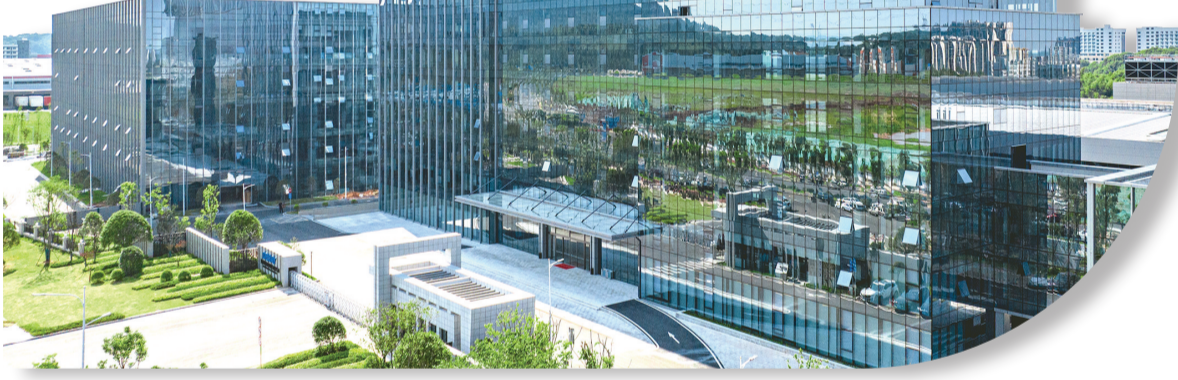
德赛电池储能电芯项目一期。
