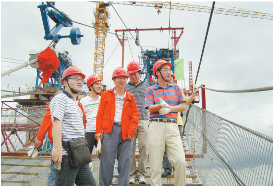
胡建华(右一)在桥梁建设现场。 通讯员 摄
