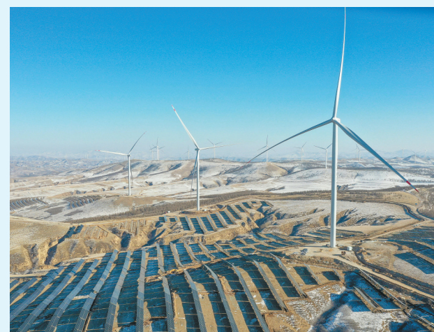
近期，位于河北省丰宁满族自治县坝上地区的承德丰宁风光氢储100万千瓦风光项目建设有序推进。图为1月12日拍摄的丰宁风光氢储100万千瓦风光项目(无人机照片)。
