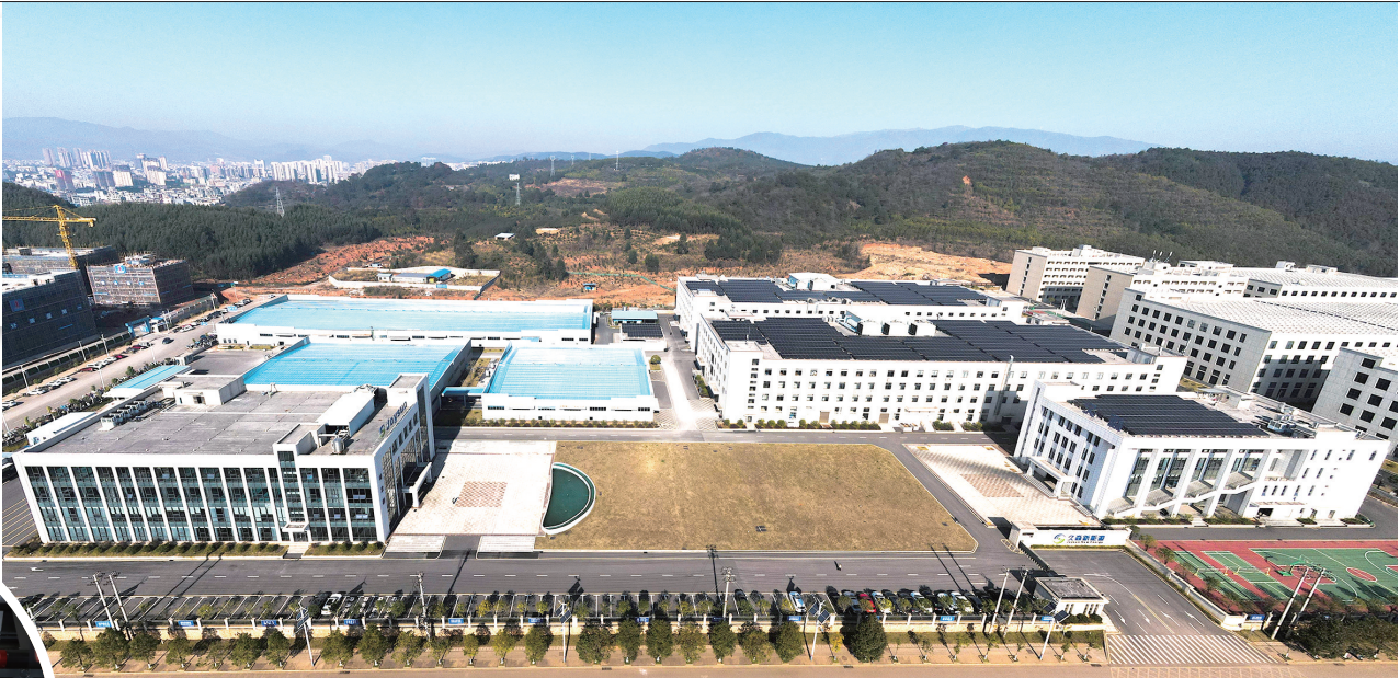
临武高新区锂电项目建设现场。
