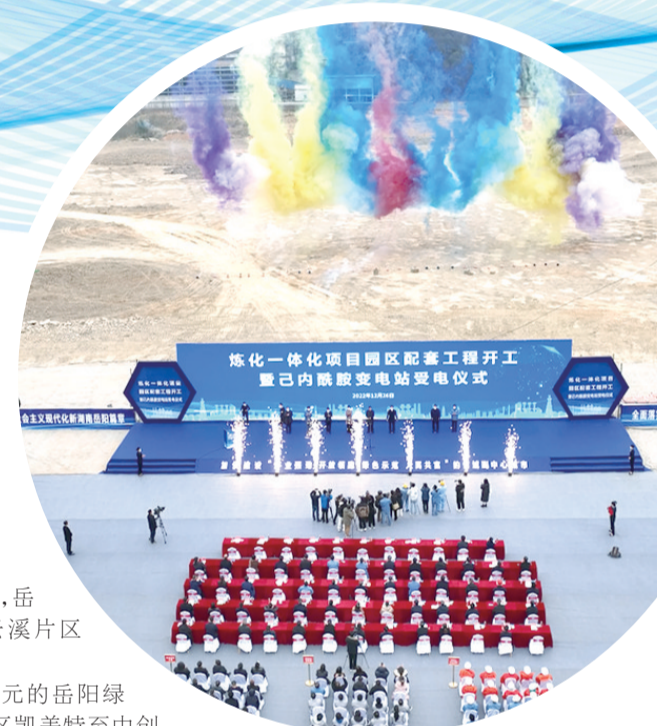
炼化一体化项目园内配套工程开工暨己内酰胺变电站受电仪式。
