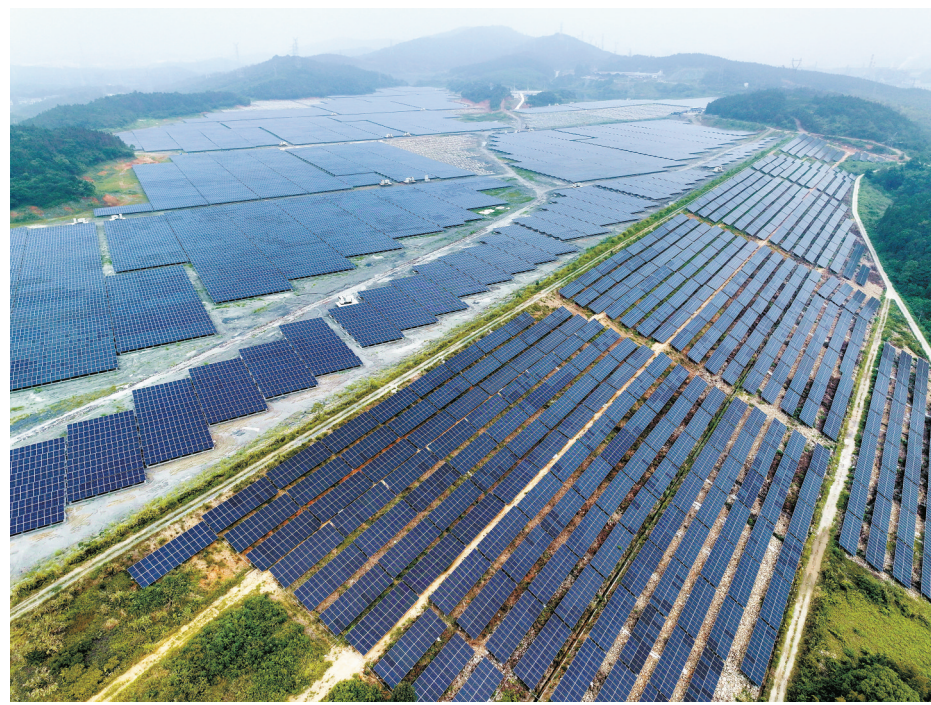
2023年12月28日21时，华润电力鲤鱼江电厂灰场环境治理及综合利用60MW光伏项目全容量并网成功。该项目位于资兴市东江街道上灶坪村，总投资2.8亿元，预计年平均发电量6929万千瓦时。 李泽南 摄
