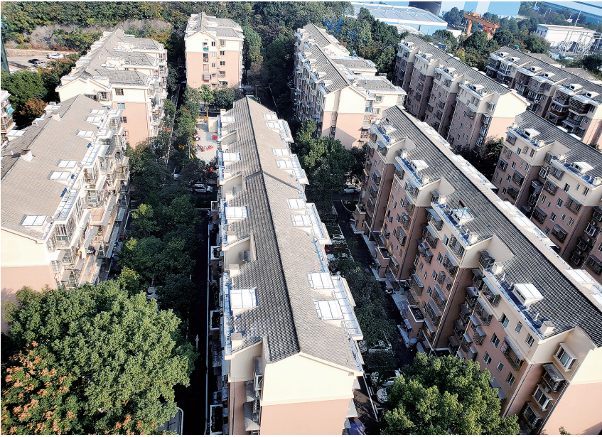
改造后的桔洲新苑小区。
