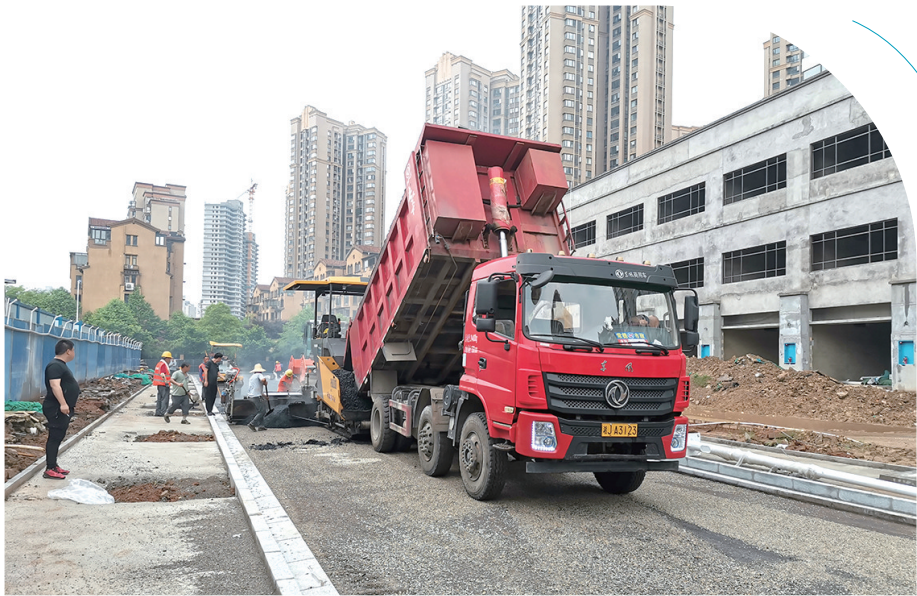
武陵区栗家巷道路改造现场。
