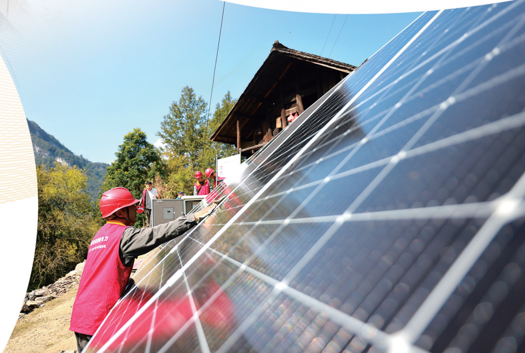
国网常德供电公司东方红（电骡子）共产党员服务队队员到南山台区为独居老人安装光伏储能设备，提升山村客户供电质量，该项目也是湖南省内光储微电网首个试点。
