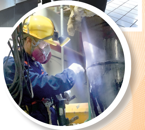
特种设备检验人员正在检查压力管道。（湖南省特种设备检测研究院供图）
