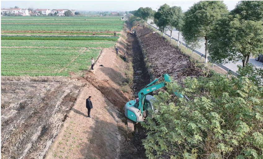
江南镇沟渠清淤施工现场。
