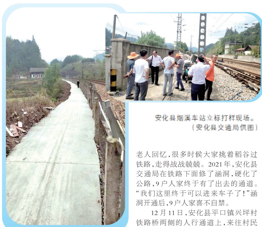
安化县烟溪镇沪昆线K1394+890人行便道。
