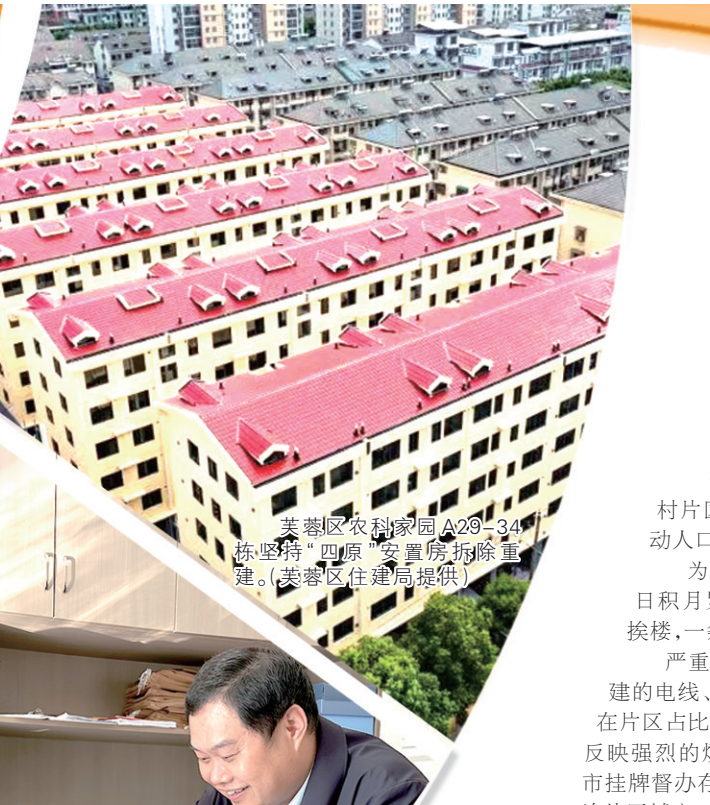
芙蓉区农科家园A29-34栋坚持“四原”安置房拆除重建。(芙蓉区住建局提供)
