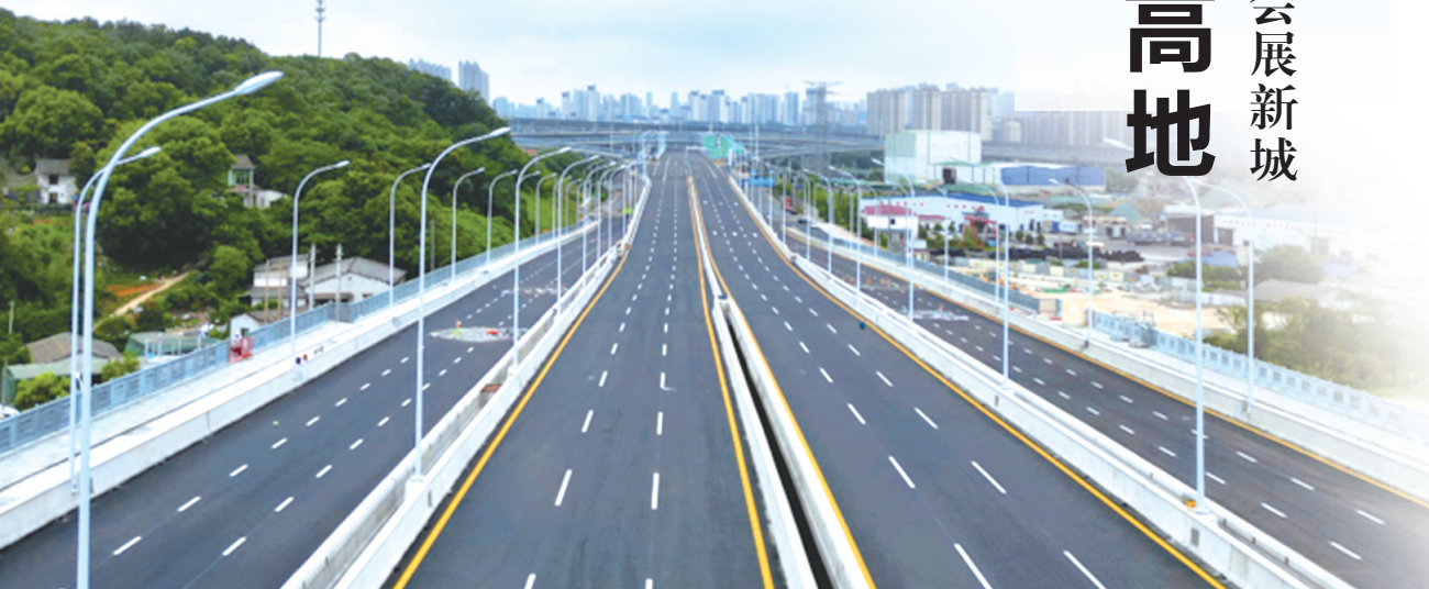
湘府东路跨浏阳河大桥。
