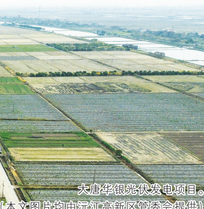
大唐华银光伏发电项目。(本文图片均由沅江高新区管委会提供)
