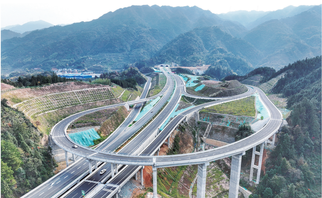
11月24日上午,芷江至铜仁(湘黔界)高速公路建成通车。湖南怀化至贵州铜仁行程,可缩短至1小时以内,我省再添一条高速公路出省通道。湖南日报全媒体记者 童迪 摄(详见2版)
