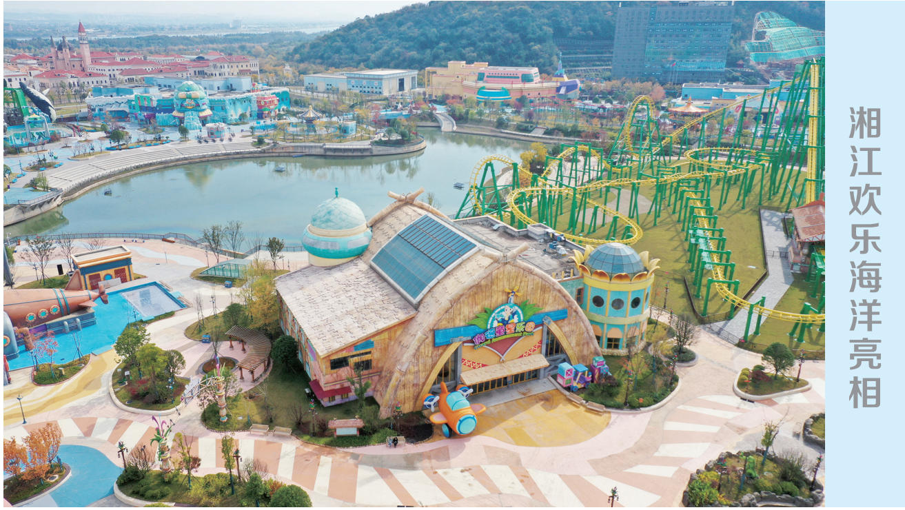
11月22日，位于湖南湘江新区大王山文旅片区的湘江欢乐海洋项目建设已完成，进入设备安装扫尾阶段。该项目是集海洋和极地动物展示、机械游乐及多媒体体验、主题演艺活动、海洋文化科普于一体的综合性大型海洋主题公园，预计下月底正式开园迎客。
