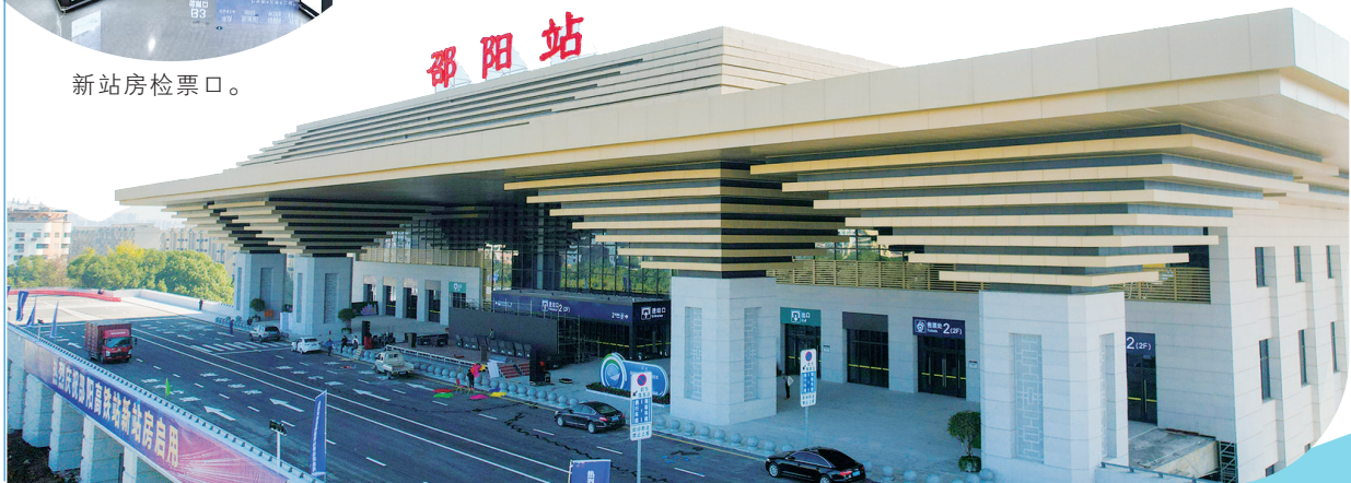
新站房进站口。
