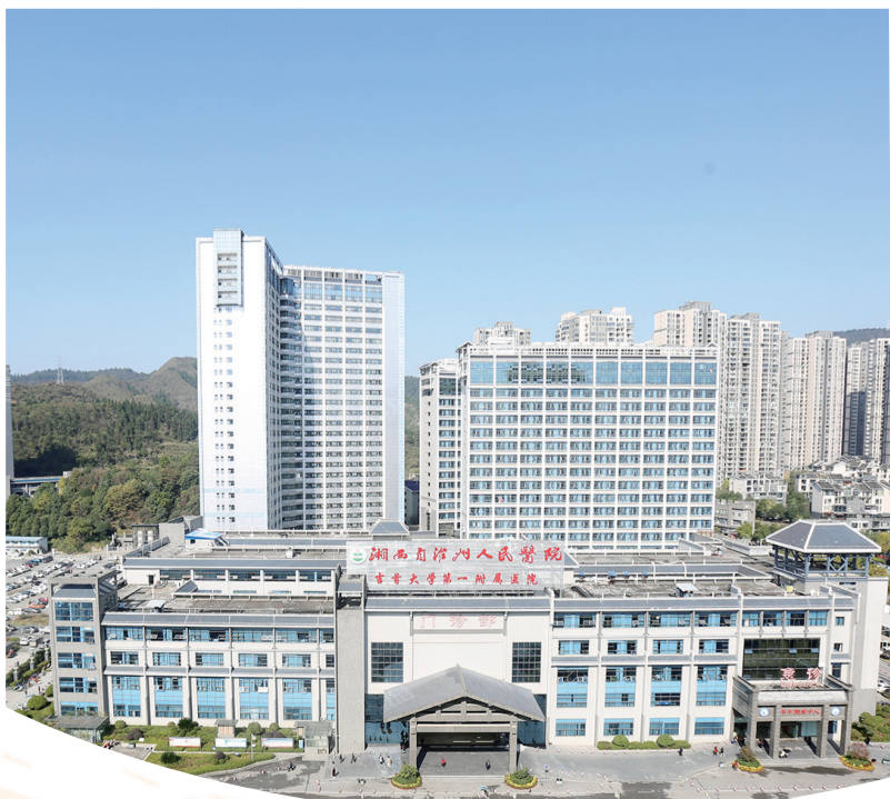
湘西州人民医院大楼新貌，该院辐射湘鄂渝黔四省(市)边区。
