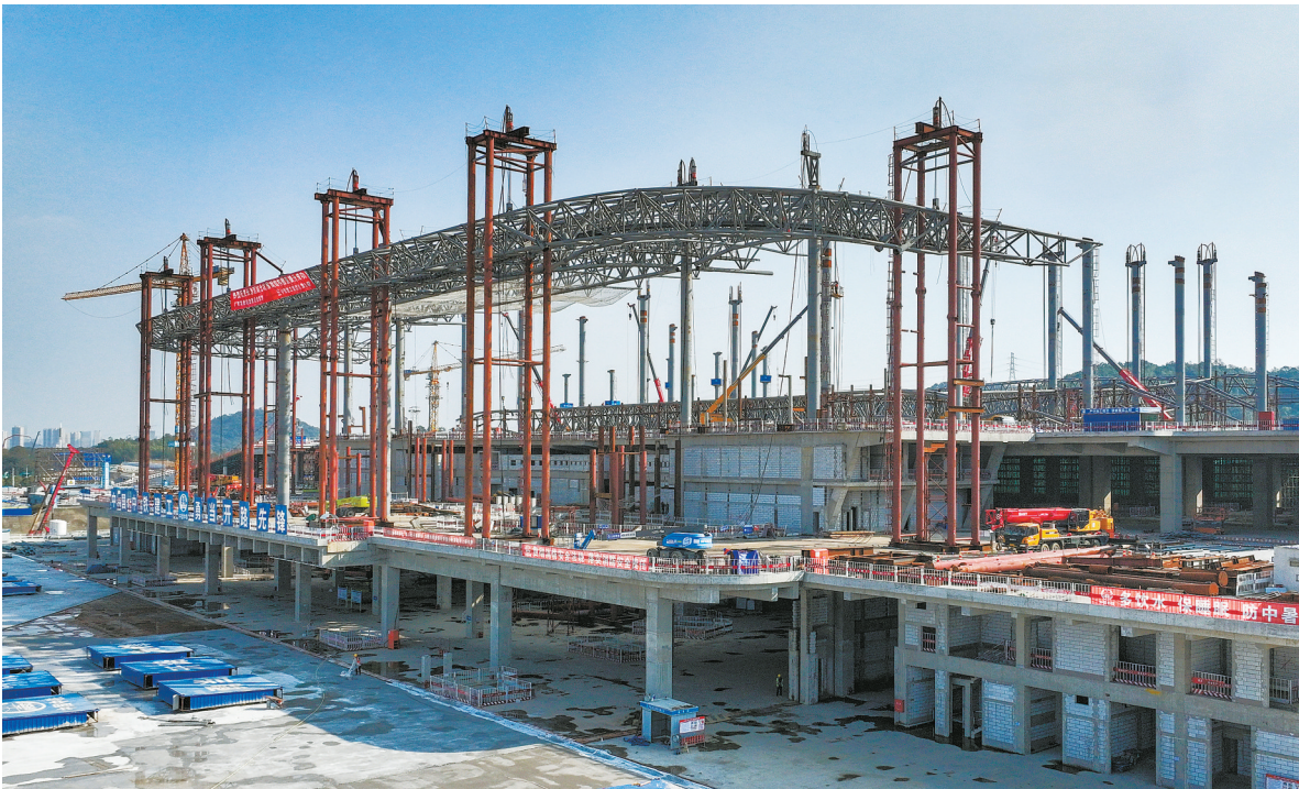
10月30日，长沙西站北站房钢结构屋盖提升施工现场。
