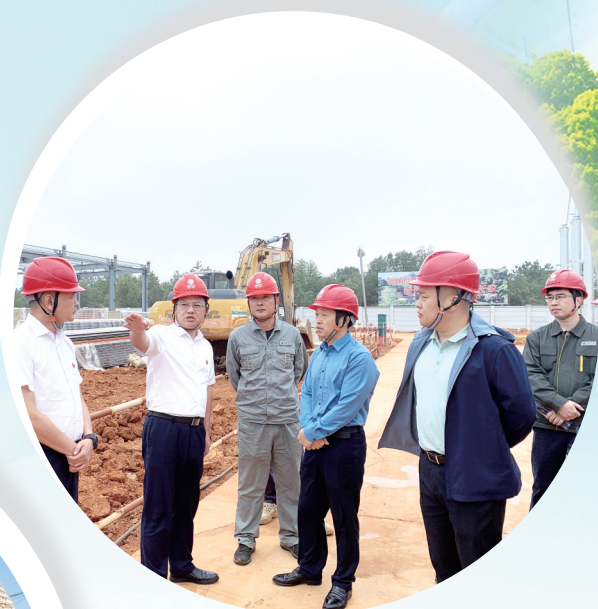
韶山市委主要领导调研徐家湾220KV变电站施工建设情况。 蒋波 摄
