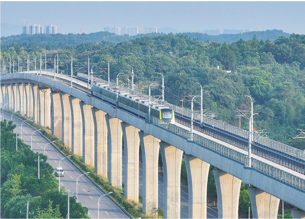
8月14日,长株潭城轨西环线,地铁列车准备驶入坪塘站。6月28日,长株潭西环线一期工程正式开通运行,长沙、湘潭首次实现地铁系统跨城市互联互通。
