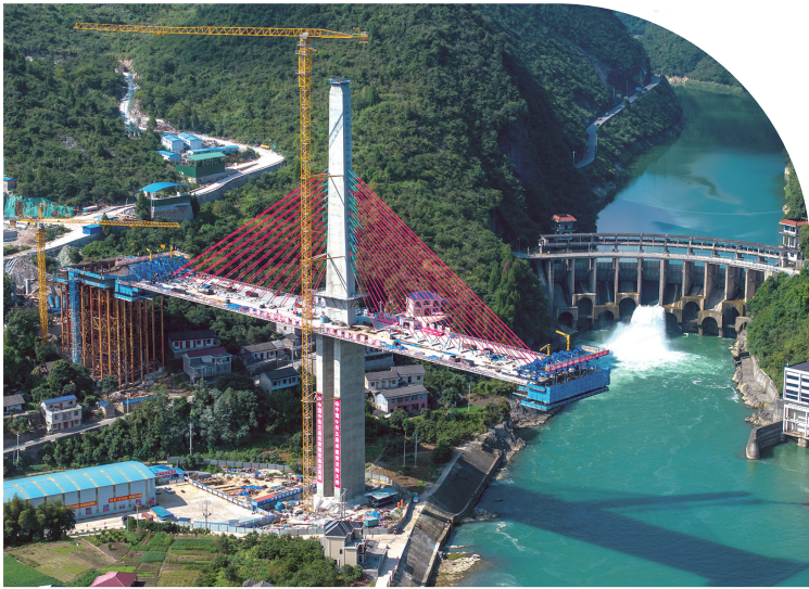
桑龙高速贺龙特大桥施工现场。
