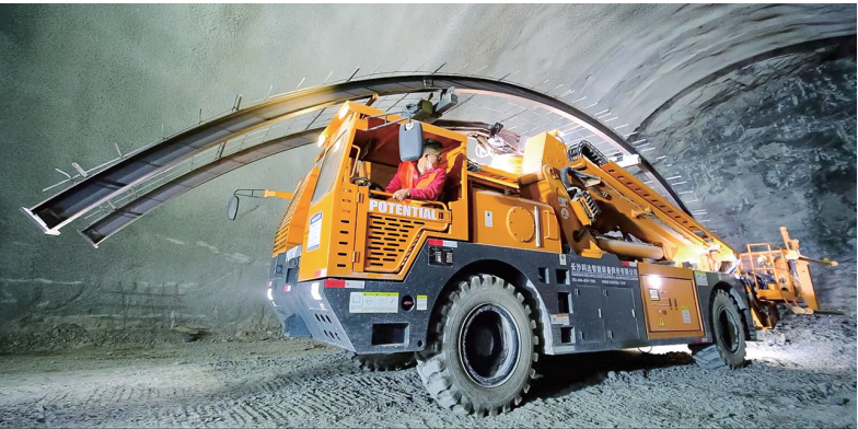
桑龙高速雷家山隧道内机械轰鸣，工人们正在施工。（资料图片）
