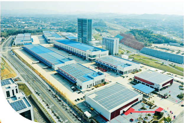
胥家桥综合物流园。
