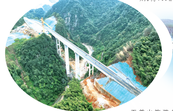
五盖山旅游公路龙形寨大桥路段。
