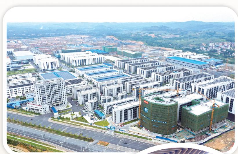
先进装备制造产业综合体标准厂房项目建设现场。
