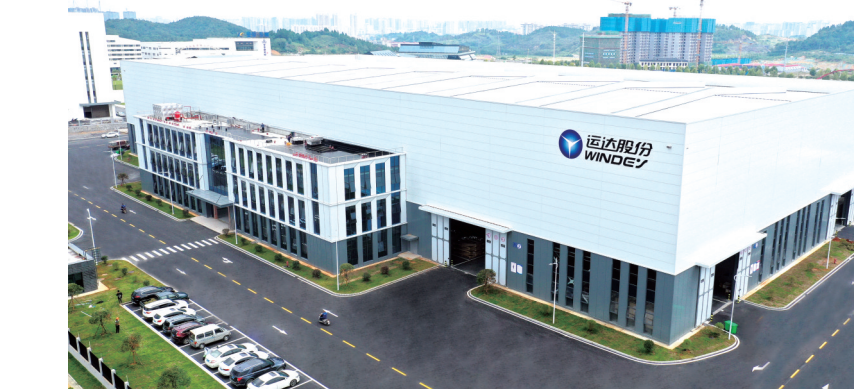
运达股份永州风电产业园。
