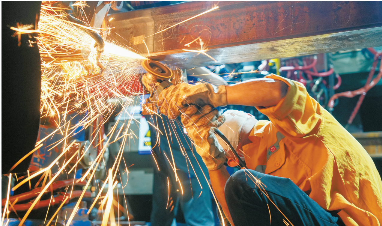
京广高铁换轨施工
