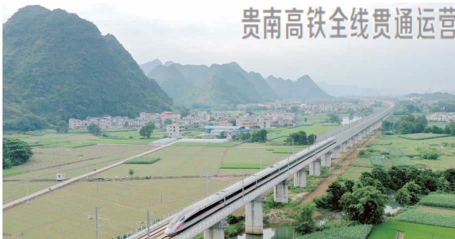
继新建贵阳至南宁高速铁路贵阳至荔波段8月8日开通运营后，南宁至荔波段将于8月31日开通运营。届时，贵南高铁实现全线贯通运营。图为8月30日，新型复兴号动车组列车在贵南高铁广西河池境内试跑（无人机照片）。新华社发
