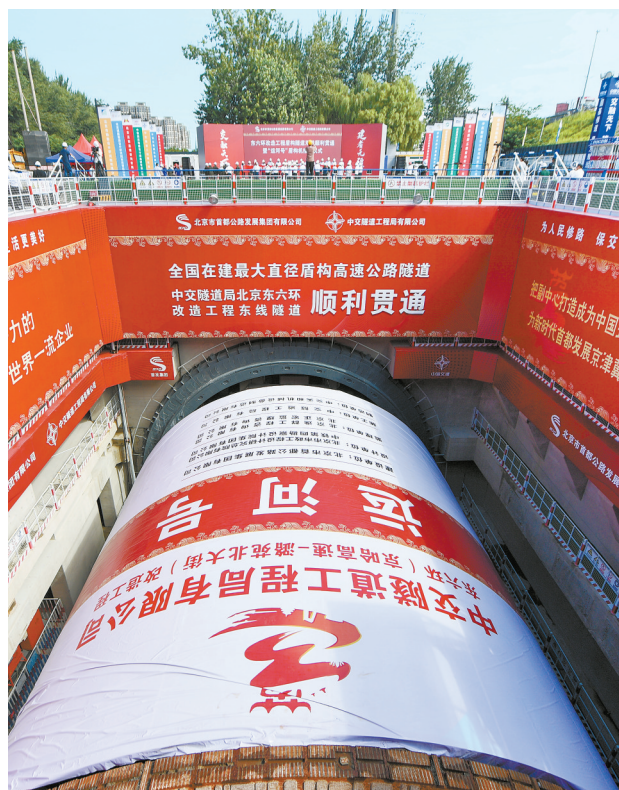
8月21日，随着国产首台16米级直径盾构机“运河号”在北京市通州区土桥新桥西北侧顺利接收，北京东六环改造工程东线隧道贯通，这也标志着我国最长盾构高速公路隧道实现双线贯通。图为当日在北京东六环改造工程东线隧道接收井中拍摄的“运河号”盾构机。新华社发
