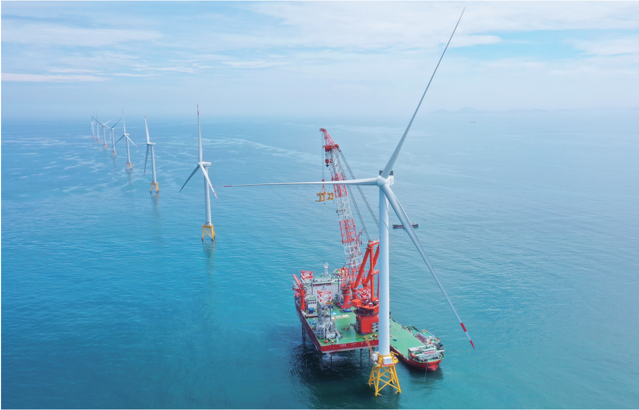
全球首 台16兆瓦 大容量海 上风电机 组在福建 北部海域 安装完成 (2023年6 月28日摄 ，无人机 照片)。 新华社发
