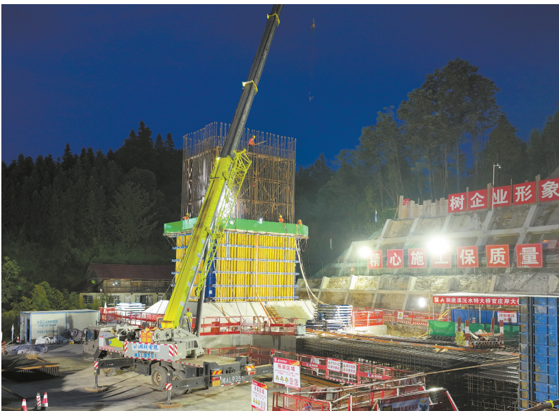
8月5日22时许,沅陵县清浪乡,工人在张官高速洞庭沅水特大桥项目工地加紧施工。 湖南日报全媒体记者 童迪 摄
