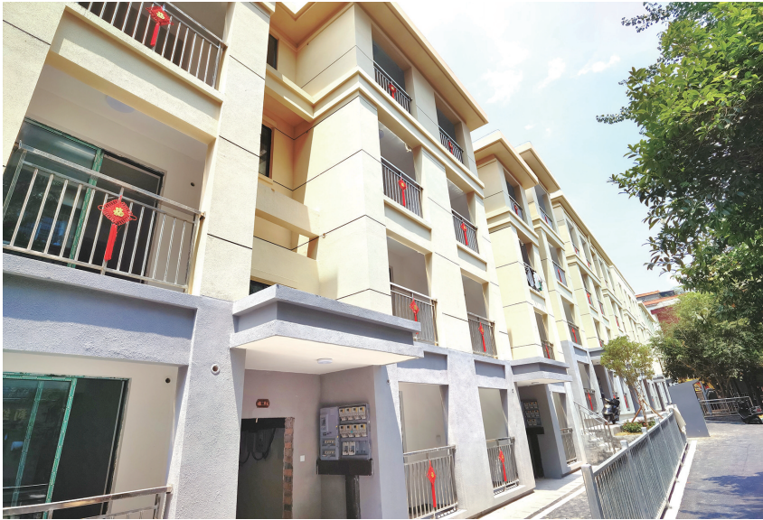
里仁坡2、3、4栋危房原址重建后的新房。
