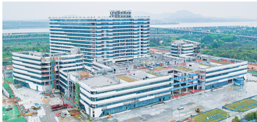
望城区人民医院整体搬迁项目。
