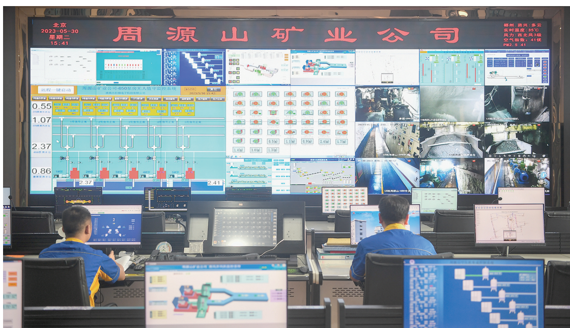
5月30日，资兴市周源山矿业公司调度指挥中心，工作人员在实时监测井下通风、排水等系统运行情况以及采煤量、掘进量基础数据。
