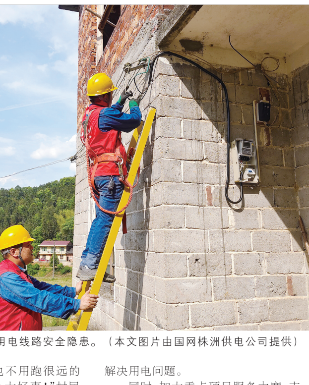
上门解决村民用电线路安全隐患。(本文图片由国网株洲供电公司提供)
