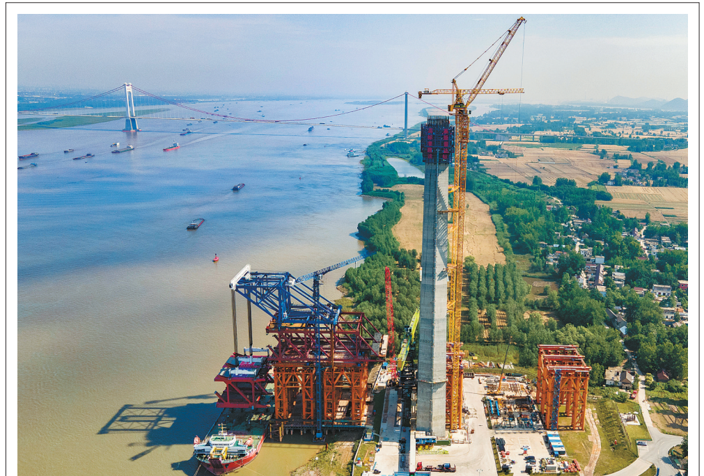
5月28日,马鞍山长江公铁大桥正在进行主汉航道桥南侧首节段钢桁梁吊装(无人机照片)。马鞍山长江公铁大桥是巢马城际铁路的关键控制性工程。该大桥的建成,将助力长三角一体化发展和长江经济带建设。 新华社发
