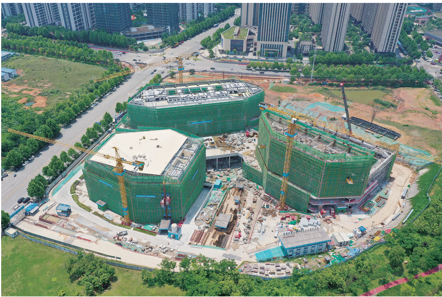
5月24日，由长沙市公共工程建设中心建设的长沙市第三工人文化宫项目已完成主体施工，进入装饰装修阶段。该项目位于尖山湖公园旁，是长沙市“十大公共服务设施项目”之一，预计今年年底达到竣工验收条件。湖南日报全媒体记者 田超 王文 摄影报道
