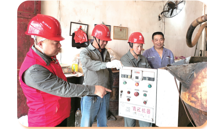
供电网格员在榨油作坊帮助村民排查用电隐患。
