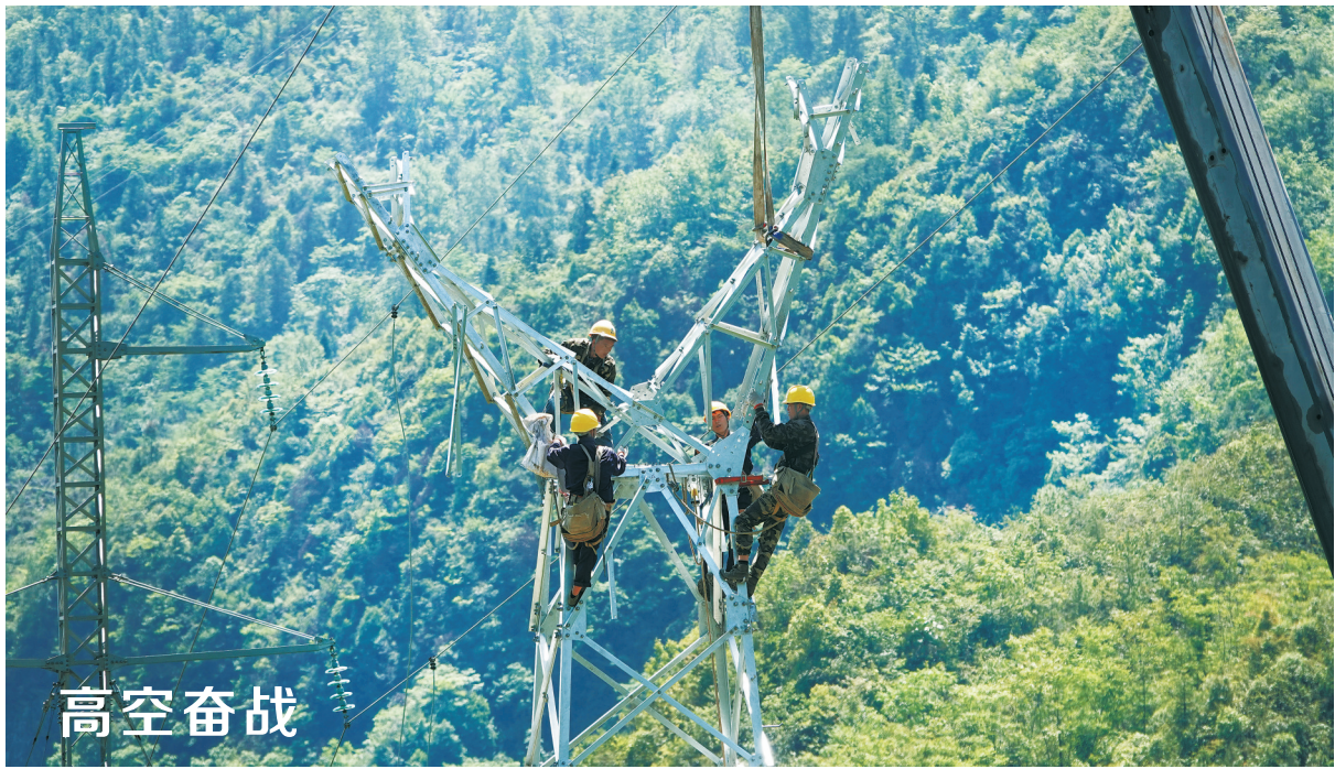
5月17日,龙山县茅坪乡干坝村,施工人员利用起吊设备进行35千伏铁塔组立作业。该铁塔属于桑龙高速邵市镇连接线杆线拆改迁移工程施工点。为“礼让”公路建设,该县积极实施红线图内的电力、通信杆线拆改迁移,打通建设施工通道。
