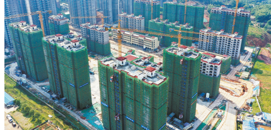
5月8日，长沙市开福区荷叶美苑农民安置房项目，13栋住宅楼主体已实现全面封顶，正在进行外立面施工。该项目总投资6.5亿元，估计年底竣工，可提供安置指标1232个。
