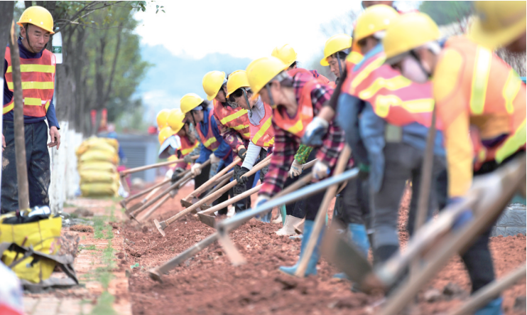
近日，第二届湖南旅发大会1号观摩路线“苏仙北路—高铁西站—北湖机场”提质项目同福路施工现场，施工人员正在加紧施工。 曹高林 摄
