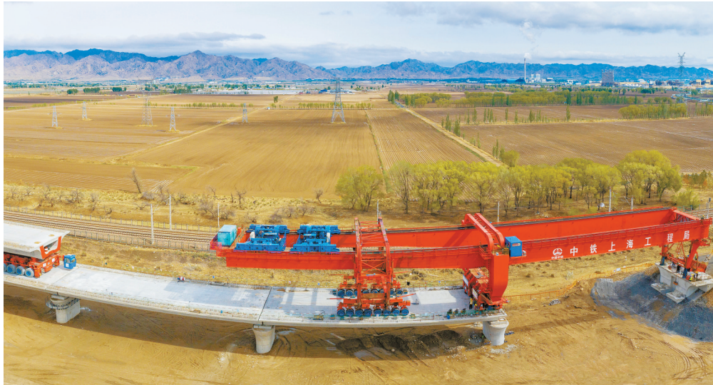
5月5日，包(头)银(川)高铁跨万甘铁路特大桥箱梁架设任务完成，图为施工现场(无人机照片)。包银高铁是我国“八纵八横”高速铁路网京兰通道的重要组成部分，设计时速250公里。 新华社 发
