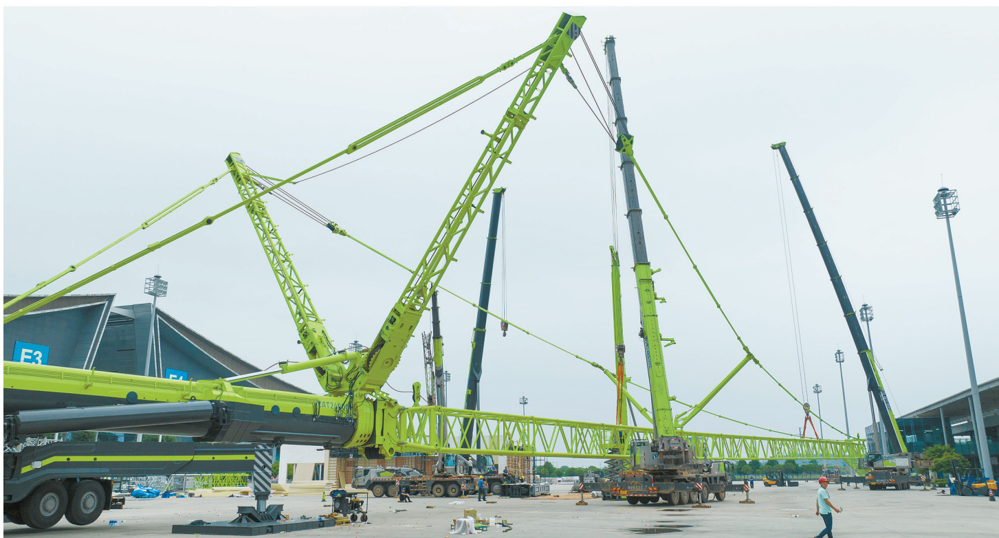
5月5日,长沙国际会展中心,中联重科2400吨全地面起重机布展工作紧锣密鼓进行。第三届长沙国际工程机械展进入倒计时,多家全球工程机械50强企业进场布展。
