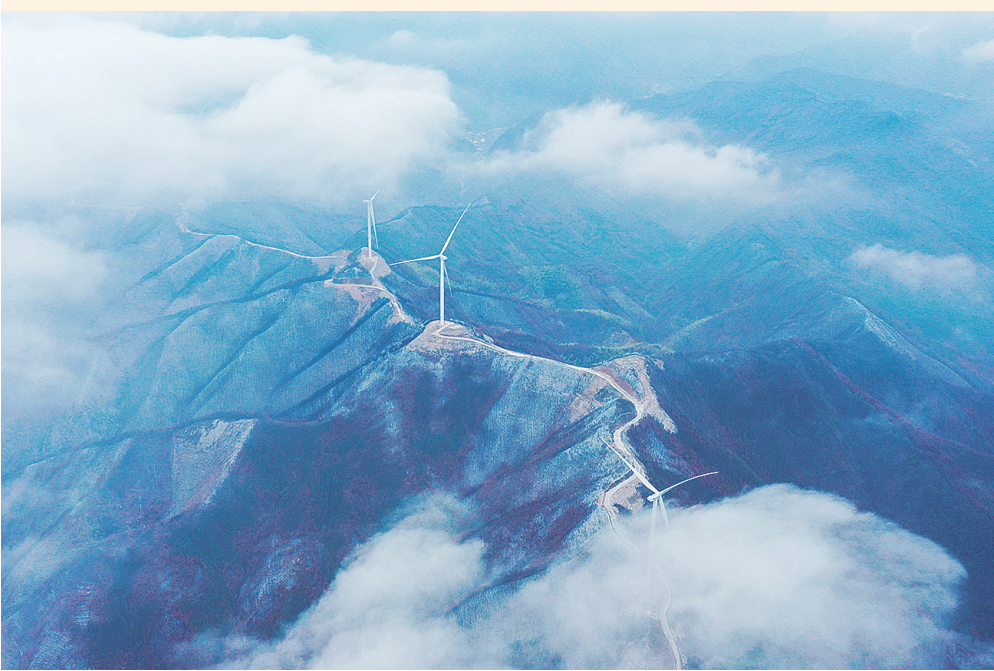
新田县门楼下瑶族乡九峰山风力发电场。(资料照片)
