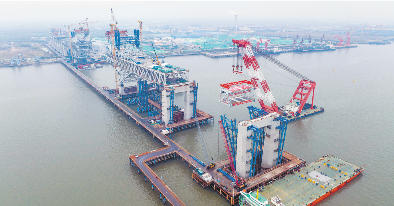
3月20日,常泰长江大桥主航道桥钢桁梁架设工作全面展开。常泰长江大桥是一座公铁两用斜拉桥,连接江苏省常州市与泰州市。建成后,主航道桥主跨达1176米,将成为世界上跨度最大的斜拉桥。 图为当日,建设者在常泰长江大桥主航道桥泰州侧施工现场进行首节段钢桁梁架设(无人机照片)。 新华社发
