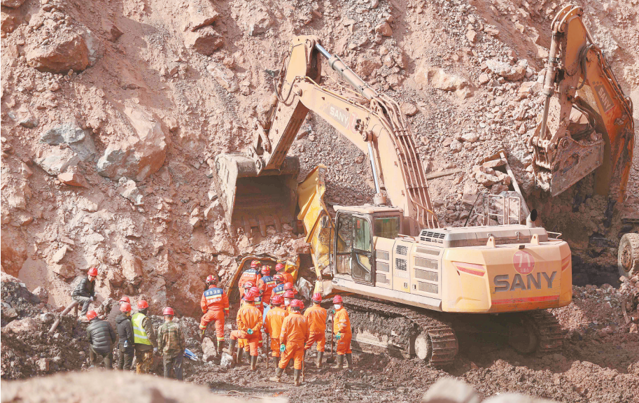
2月22日13时许，内蒙古自治区阿拉善盟阿拉善左旗新井煤业有限公司露天煤矿发生大面积坍塌。目前救援人员正在事故现场集结，全力开展救援工作。图为内蒙古自治区消防救援总队指战员在事故现场实施救援。 新华社发
