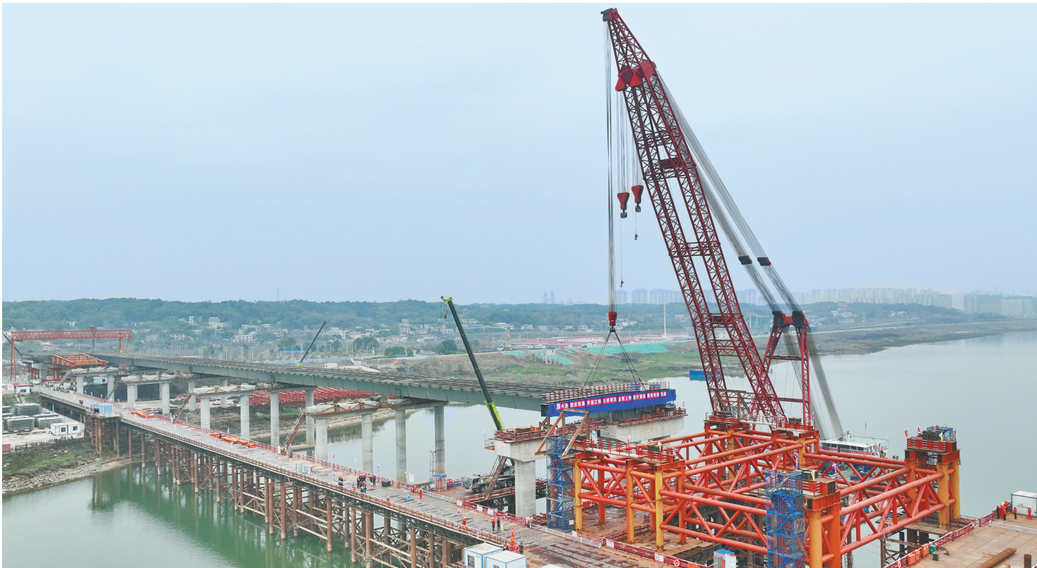
2月20日，长沙暮坪湘江特大桥项目现场，主桥首片钢梁完成吊装，标志着该项目主桥全面进入上构施工阶段。暮坪湘江特大桥是浏阳澄潭江至宁乡沙田公路工程(长沙市南横线)的过江通道，全长约4.416公里，预计2024年底建成。
